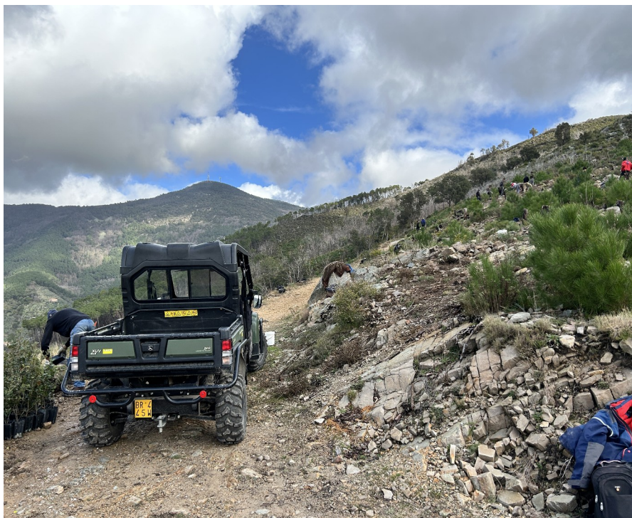
Foto 12: Attività di scavo e messa a dimora
